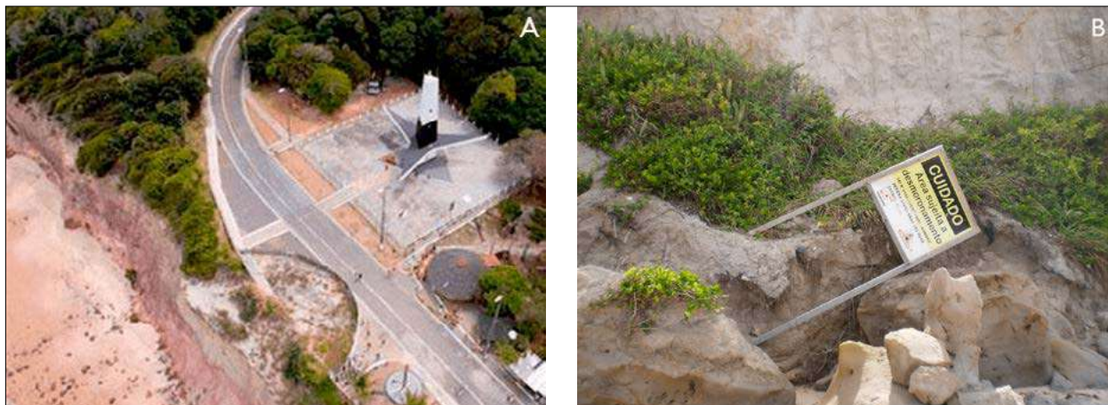
Figura 11. Situação atual da falésia de Cabo Branco: A) foto aérea do Farol do Cabo Branco, mostrando o desabamento de parte da falésia; B) base da falésia, com placa advertindo para a possibilidade de desmoronamento da área. Fotos: Luciano S. Pereira (2019).
